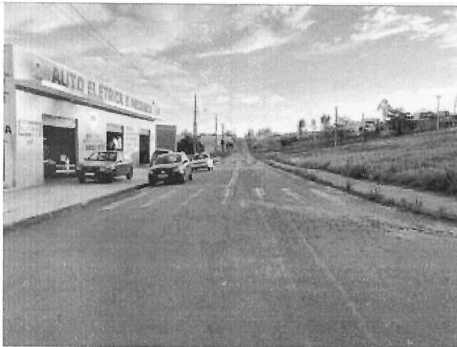
FOTO 05: Execução de revestimento, calçadas, rampas e sinalização de trânsito na Avenida Nova Aliança entre Rua Vicente Martellosso e Rua Nestor Volpato.
