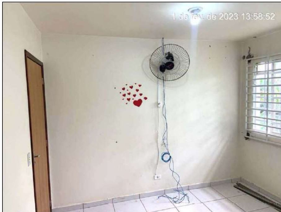
Figura 24. Vista parcial da sala de vacina atual. FONTE: Acervo Técnico da Vistoria.
