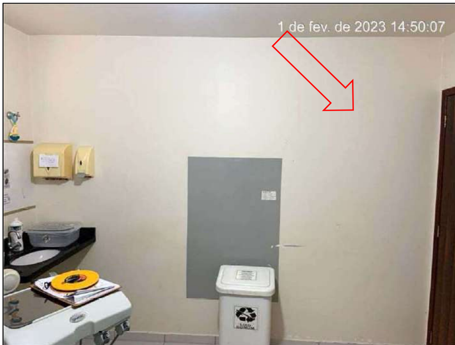
Figura 80. Vista parcial do Consultório Odontológico Infantil. FONTE: Acervo Técnico da Vistoria.
