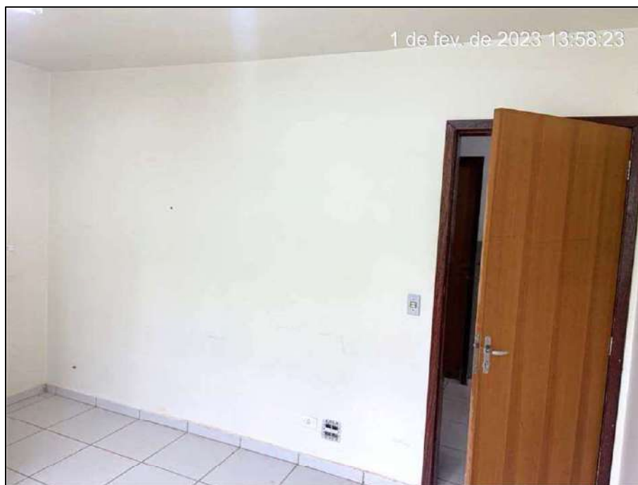
Figura 23. Vista parcial da sala de vacina atual, observando parede interna de divisa com a circulação. FONTE: Acervo Técnico da Vistoria.
