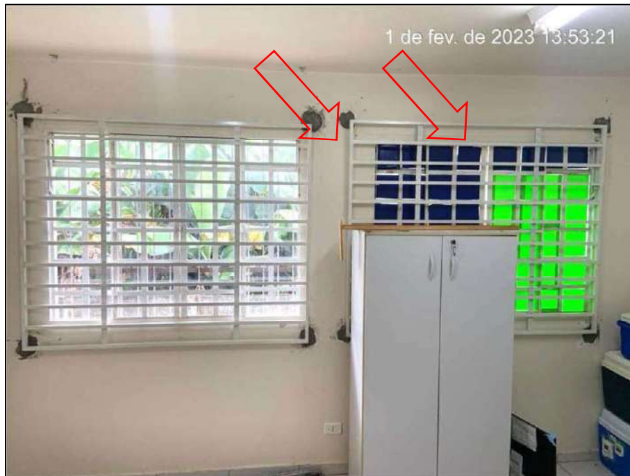
Figura 14. Vista parcial da sala de vacina atual, observando parede do fundo da EAS.
