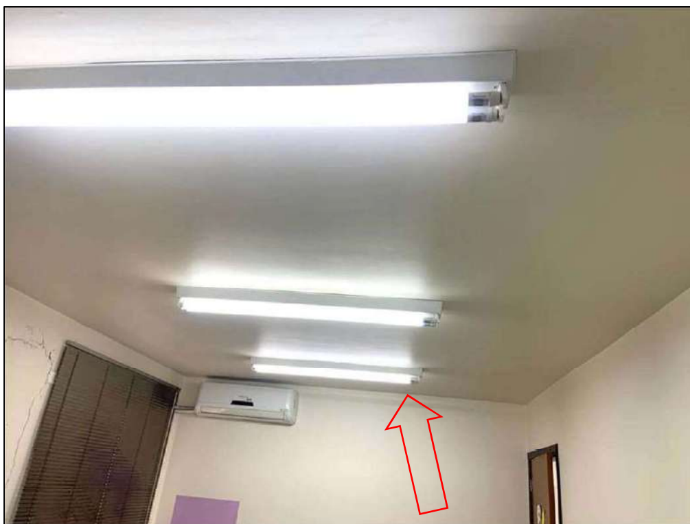
Figura 53. Vista parcial da laje de teto. FONTE: Acervo Técnico da Vistoria.
