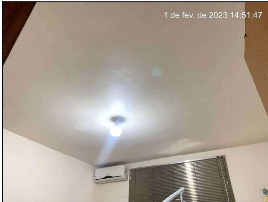
Figura 88. Vista da laje de teto do consultório odontológico infantil. FONTE: Acervo Técnico da Vistoria.
