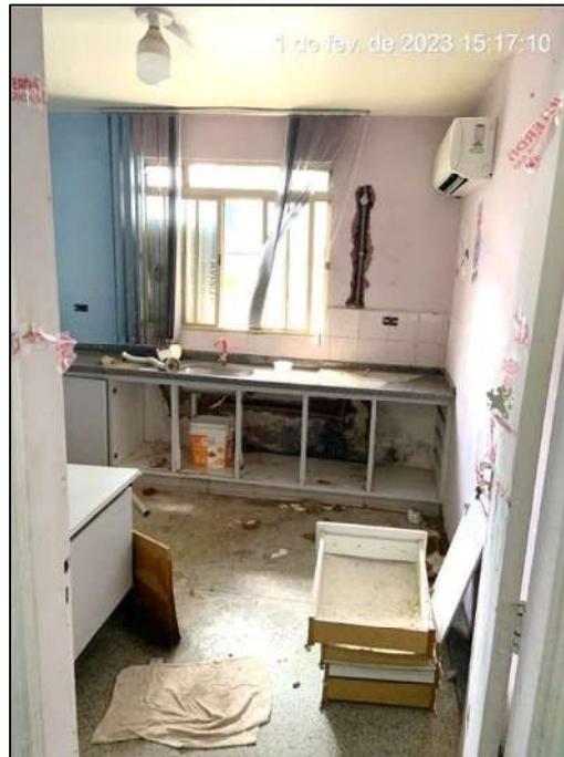
Figura 106. Vista parcial da sala antiga de vacina. FONTE: Acervo Técnico da Vistoria.
