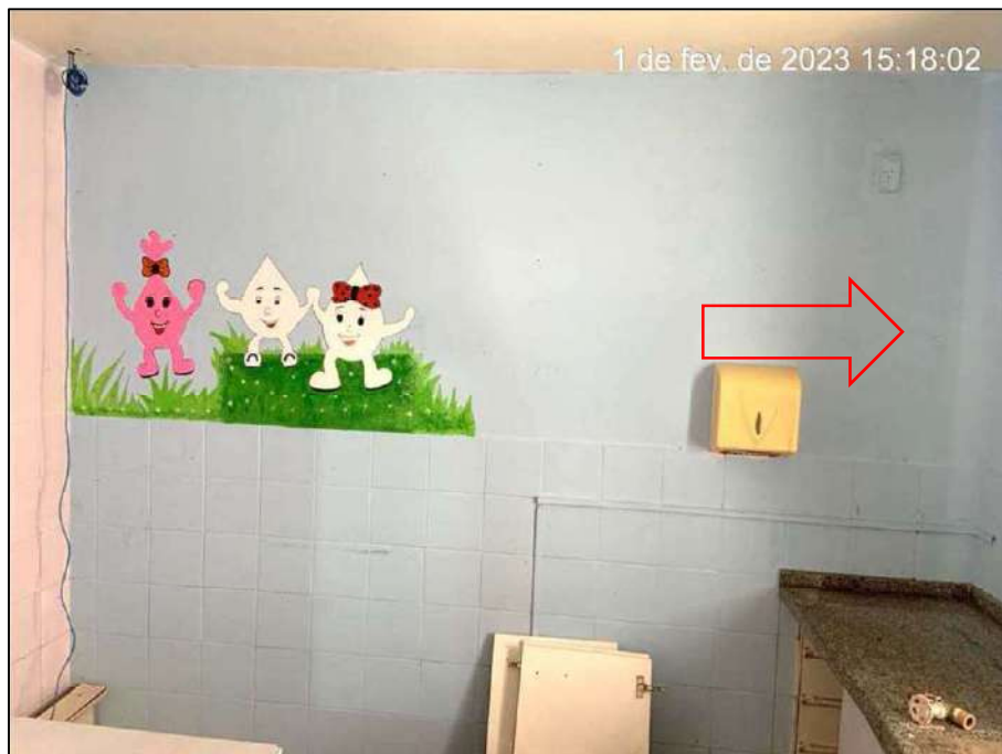
Figura 111. Vista parcial da sala antiga de vacina. FONTE: Acervo Técnico da Vistoria.
