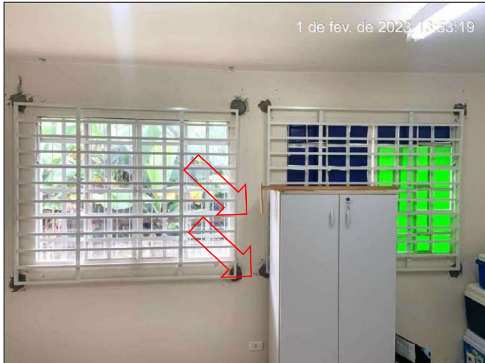
Figura 7. Vista parcial da sala de vacina, observando parede do fundo da EAS. FONTE: Acervo Técnico da Vistoria.
