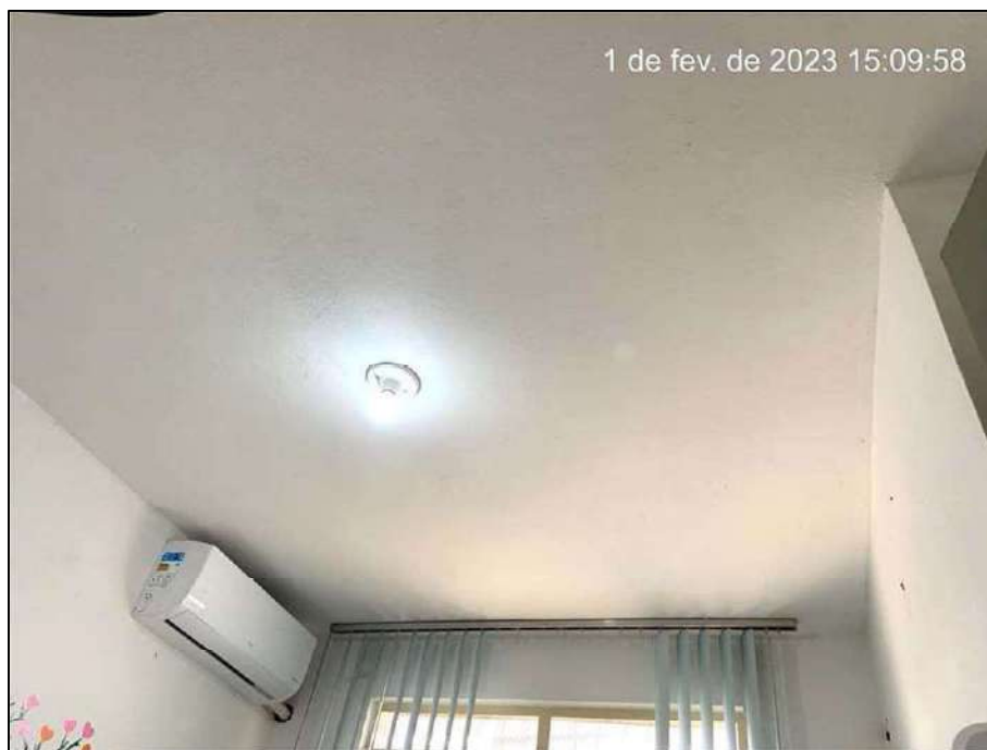
Figura 97. Vista da laje de teto do Consultório de Psicologia. FONTE: Acervo Técnico da Vistoria.
