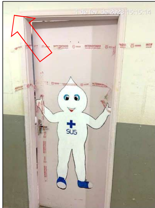
Figura 98. Vista do acesso a sala antiga de vacina. FONTE: Acervo Técnico da Vistoria.
