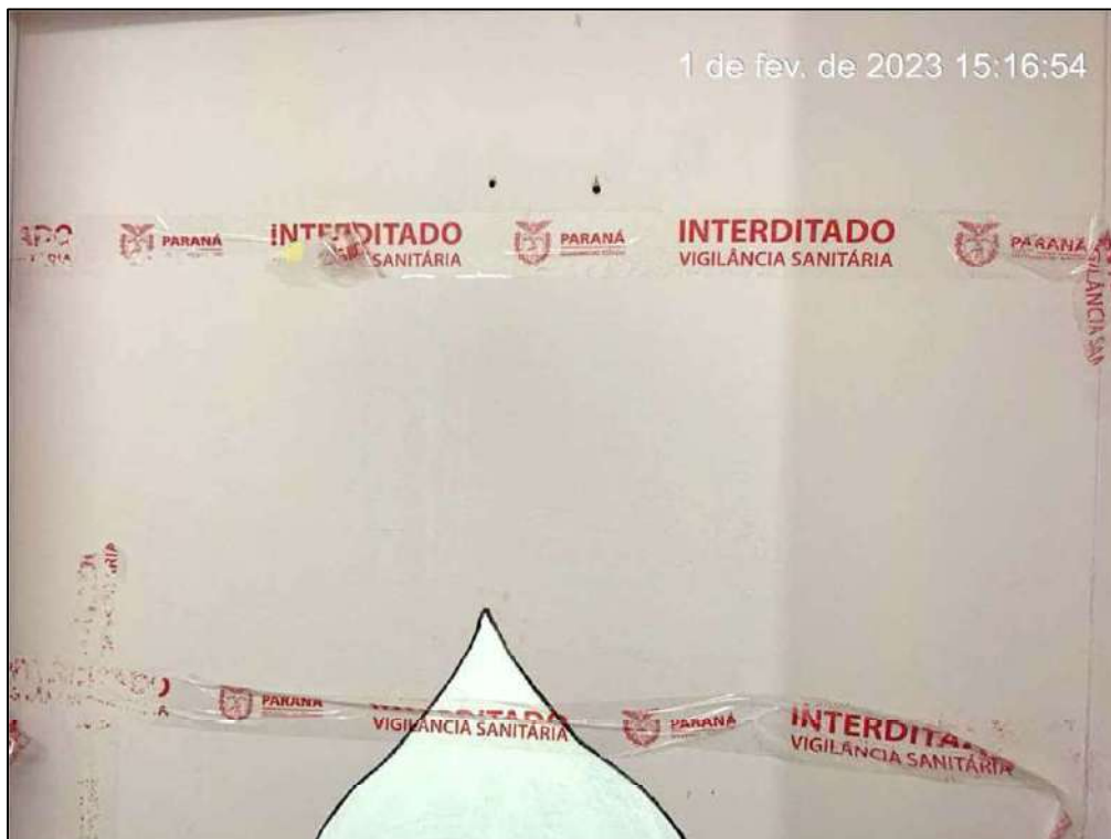
Figura 99. Em detalhe a Figura acima. FONTE: Acervo Técnico da Vistoria.
