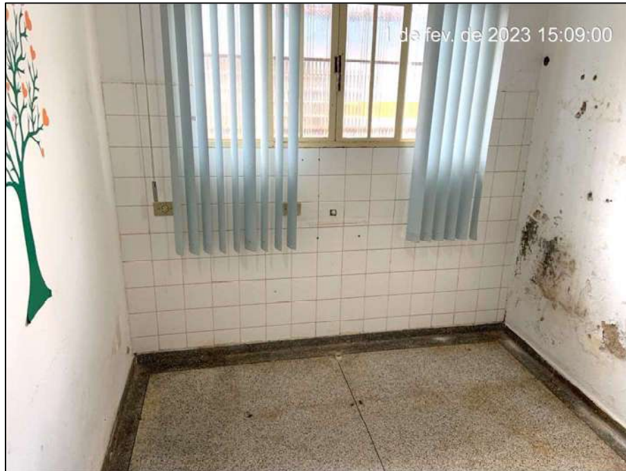
Figura 93. Vista parcial do consultório de psicologia. FONTE: Acervo Técnico da Vistoria.
