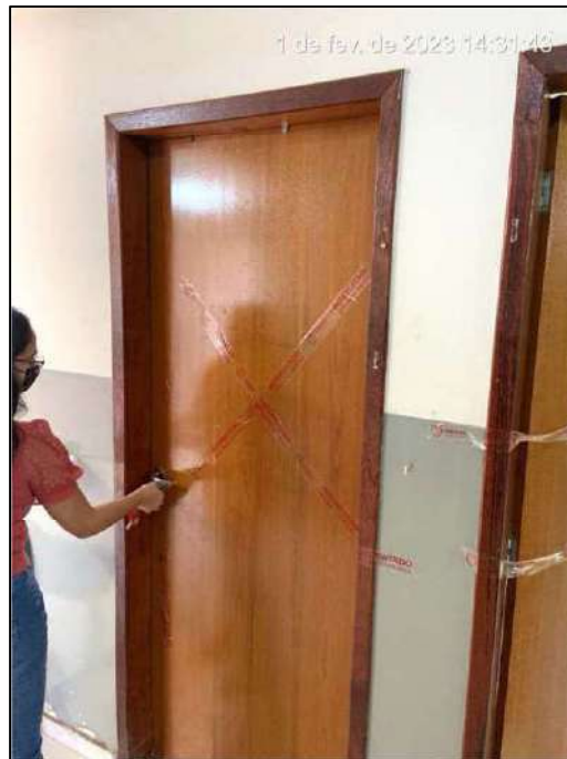
Figura 63. Vista do acesso ao Consultório Infantil. FONTE: Acervo Técnico da Vistoria.
