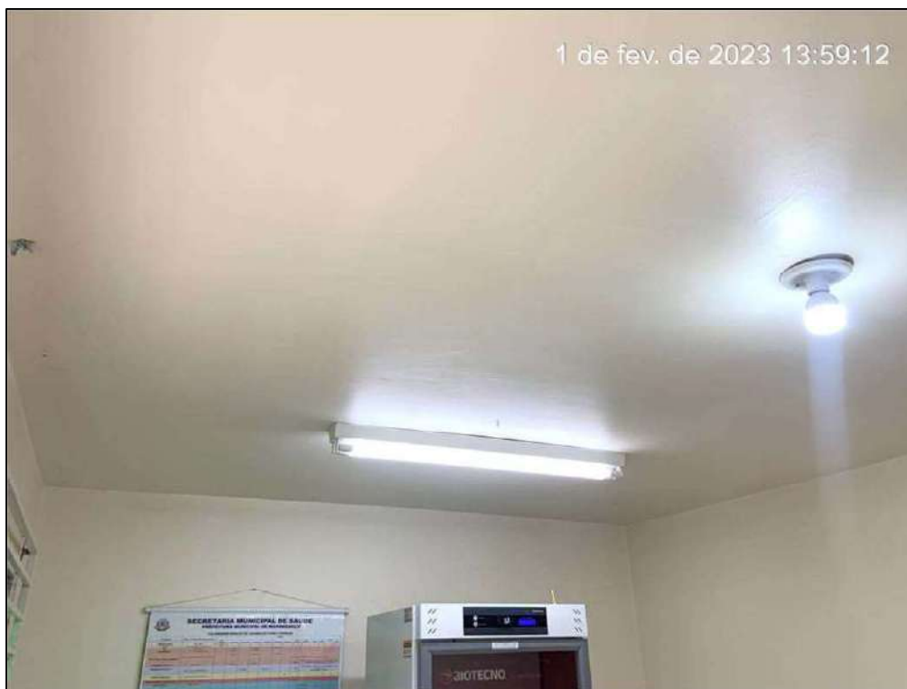
Figura 25. Vista parcial da laje de teto da sala de vacina atual. FONTE: Acervo Técnico da Vistoria.
