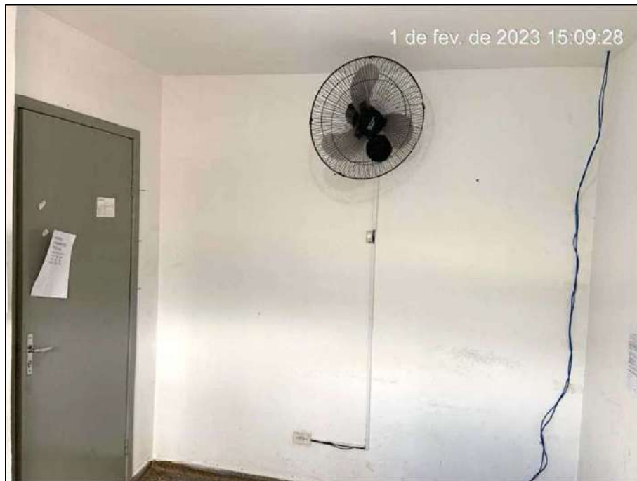
Figura 96. Vista parcial do Consultório da Psicóloga. FONTE: Acervo Técnico da Vistoria.
