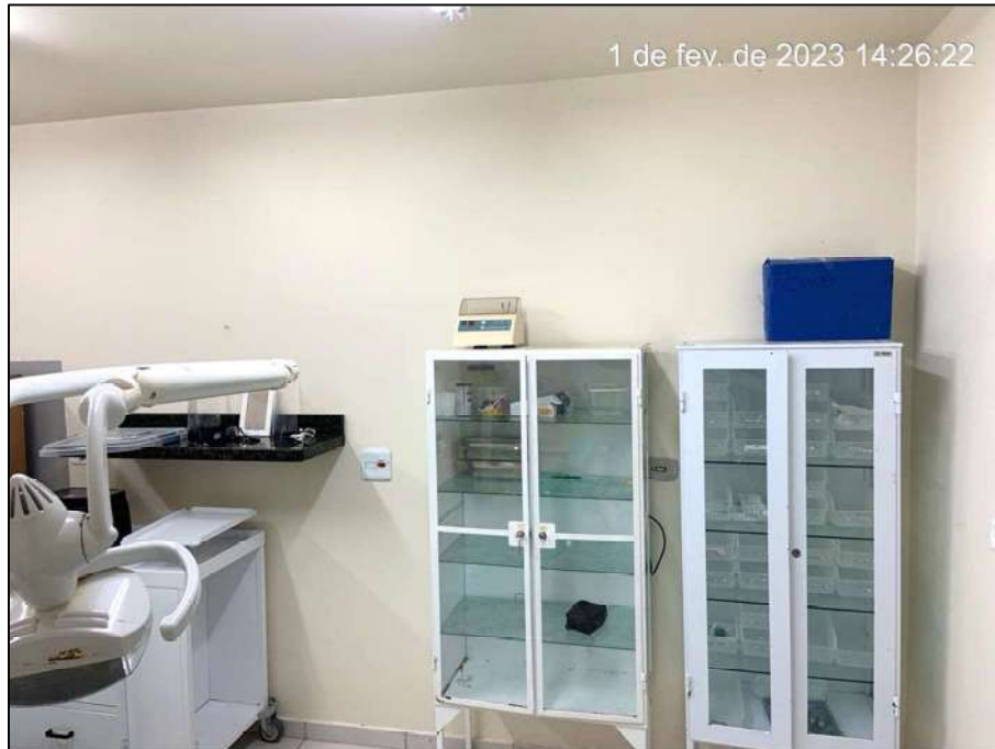
Figura 47. Vista parcial do consultório odontológico, observando parede interna de divisa com a circulação. FONTE: Acervo Técnico da Vistoria.
