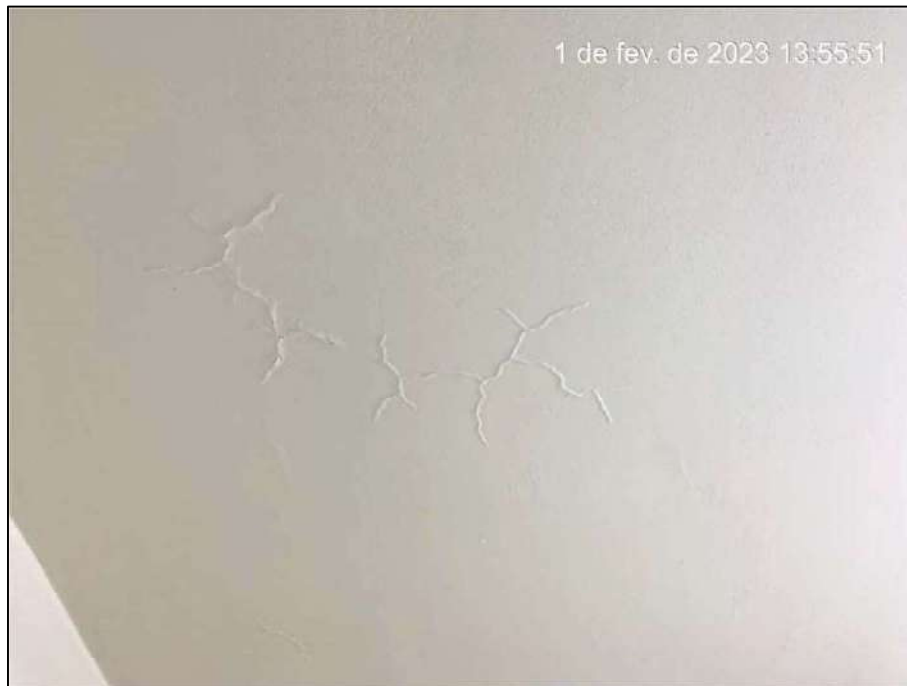
Figura 22. Outro detalhe a Figura acima. FONTE: Acervo Técnico da Vistoria.
