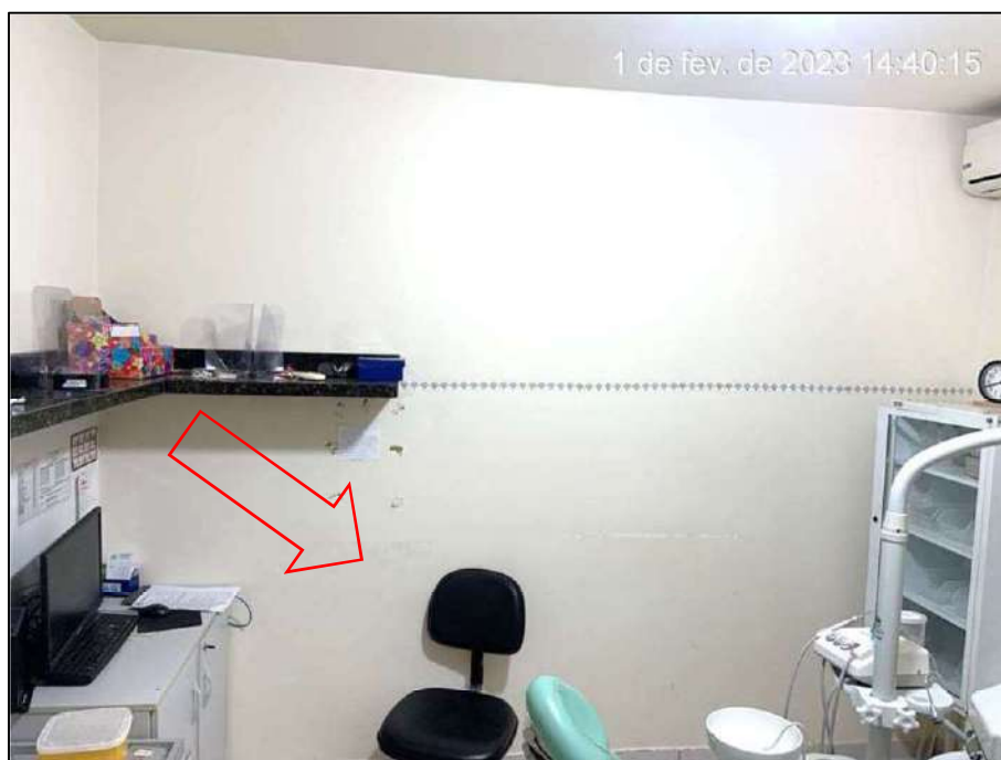
Figura 73. Vista parcial do consultório odontológico infantil. FONTE: Acervo Técnico da Vistoria.
