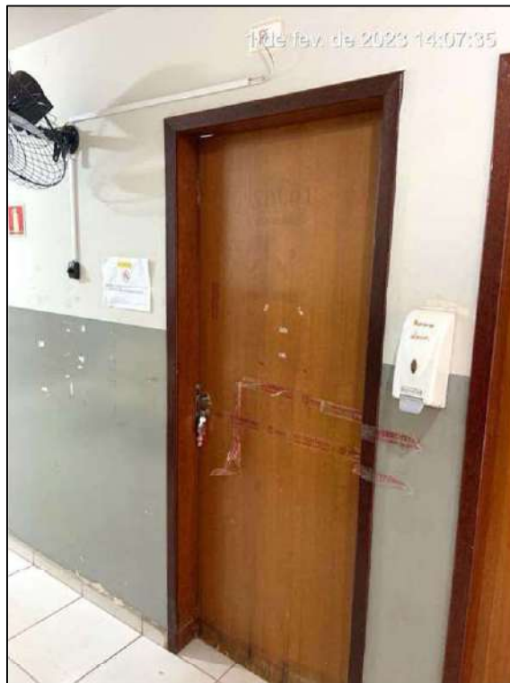
Figura 26. Vista do acesso ao consultório odontológico adulto. FONTE: Acervo Técnico da Vistoria.
