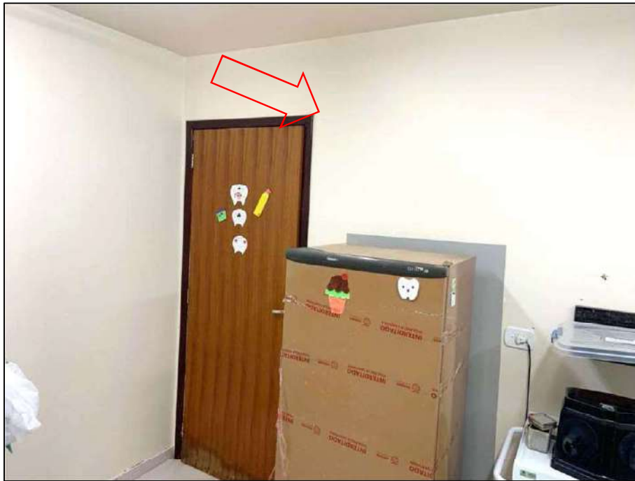
Figura 58. Vista parcial da sala odontológica. FONTE: Acervo Técnico da Vistoria.
