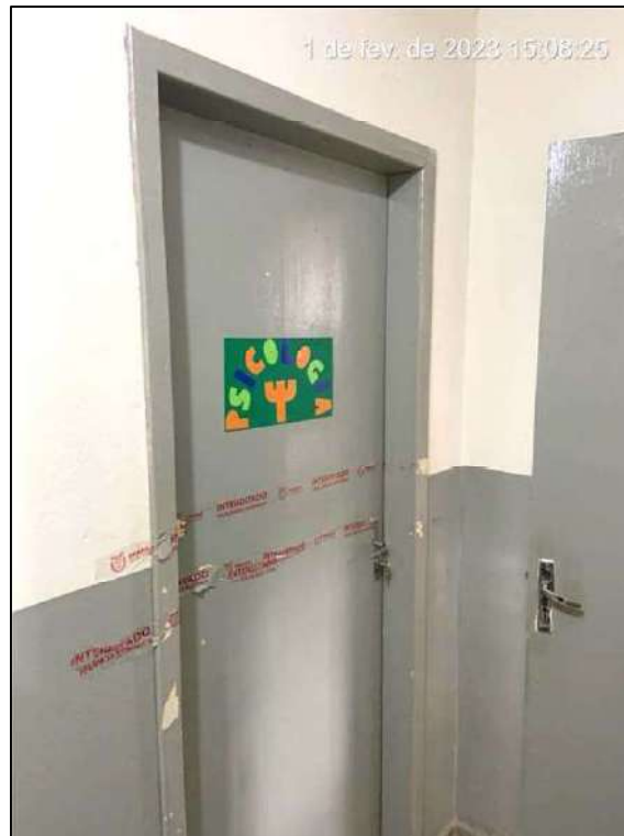
Figura 89. Vista do acesso ao Consultório Psicóloga. FONTE: Acervo Técnico da Vistoria.
