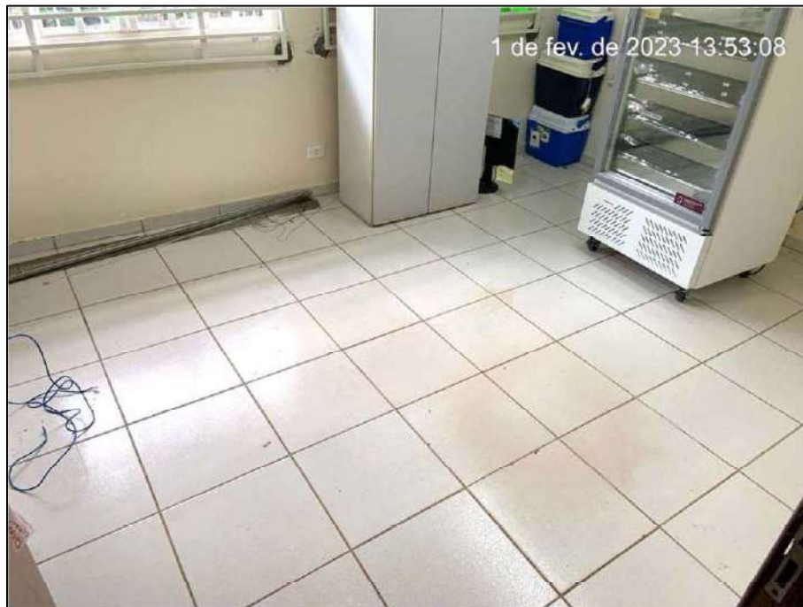
Figura 6. Vista parcial do revestimento de piso da sala de vacina - atual. FONTE: Acervo Técnico da Vistoria.
