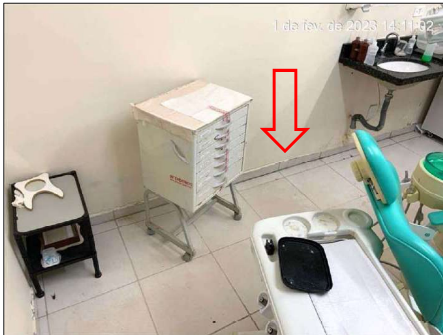
Figura 38. Vista parcial do consultório odontológico. FONTE: Acervo Técnico da Vistoria.
