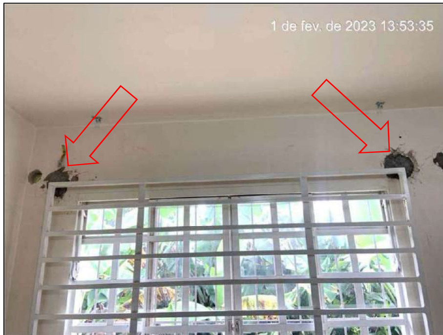
Figura 12. Vista parcial da sala de vacina - atual, observando parede do fundo do EAS, destacando ponto de chumbamento sem o revestimento decorativo (película de pintura). FONTE: Acervo Técnico da Vistoria.
